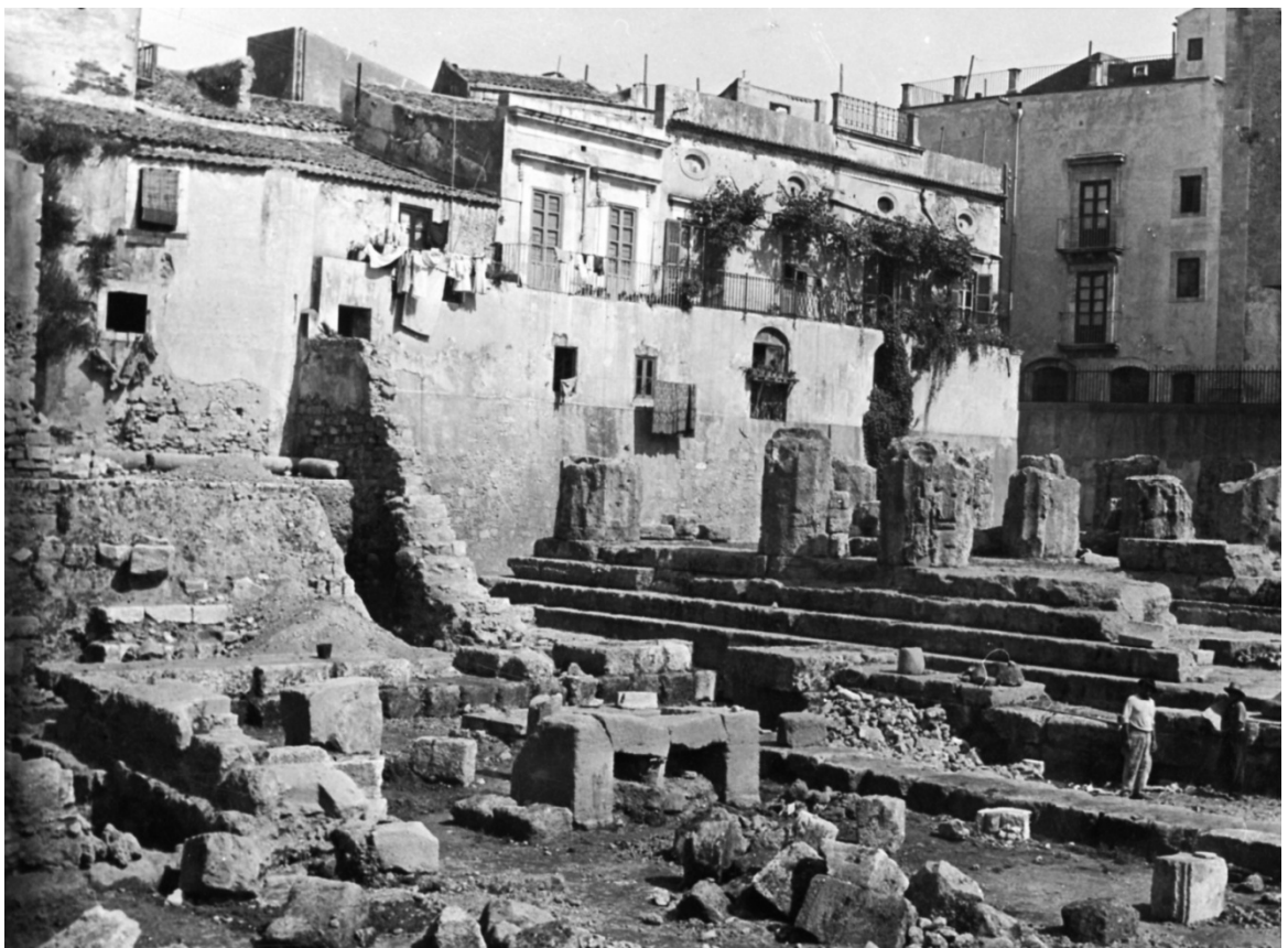
Fig. 49– Le ultime fasi delle demolizioni, 1938. Archivio storico della Soprintendenza di Siracusa.
