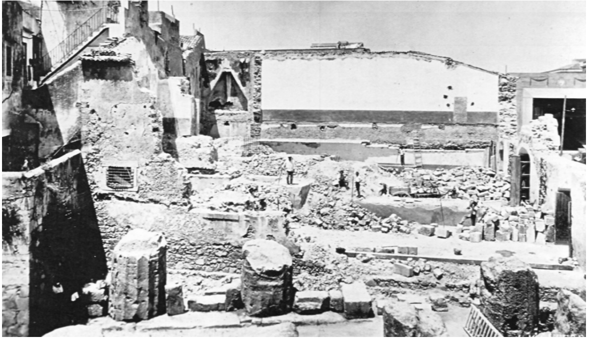
Fig. 48 – La caserma in corso di demolizione (da G. Voza, Sulla topografia di Siracusa antica , in L. Trigilia (a cura di), Annali del Barocco in Sicilia , n.8, 2005)
