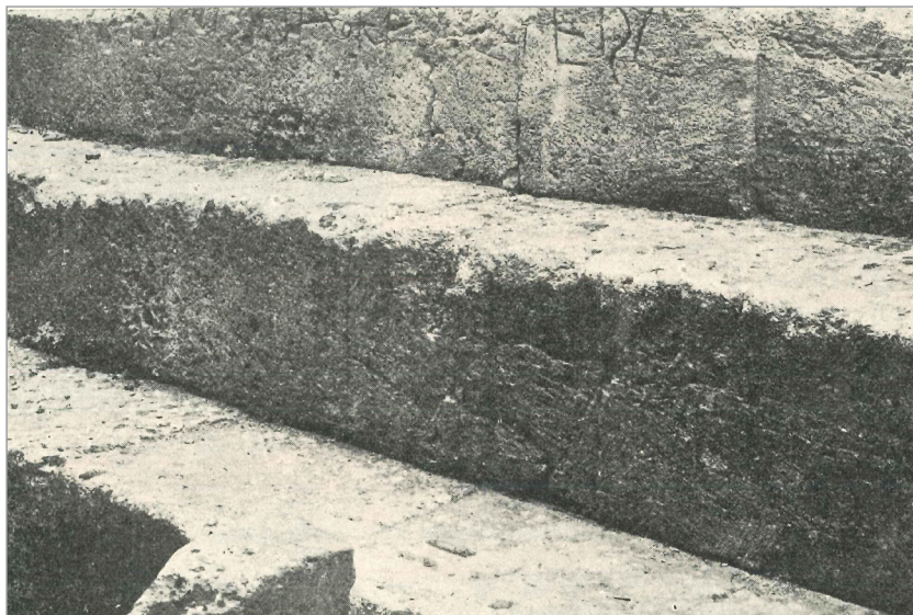
Fig. 10. Particolare dello stilobate, con le ultime lettere conservate dell'iscrizione, e dei sottostanti gradini, con gli incassi per la sistemazione della scaletta centrale; l'angolo di una spalletta è visibile in basso a sinistra (da CULTRERA 1951).
