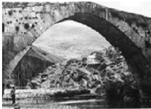
Il ponte di Karamagara Koprusu
