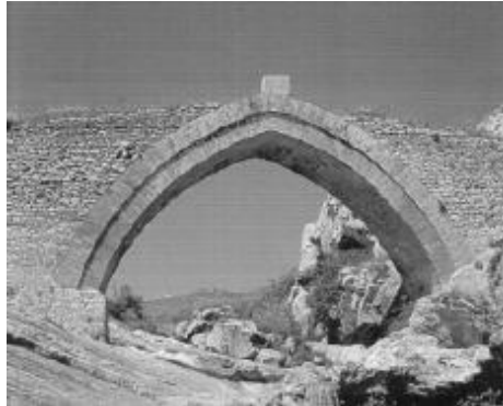
Il ponte di Calatrasi
