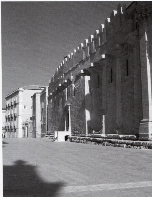
2.19 - Via Minerva dopo gli interventi: un vuoto metafisico. Foto Liistro 2008
