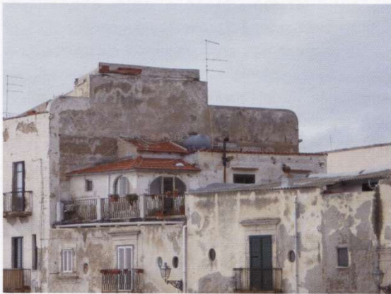
4.25 - Sopraelevazione a Lungomare Vigliena
