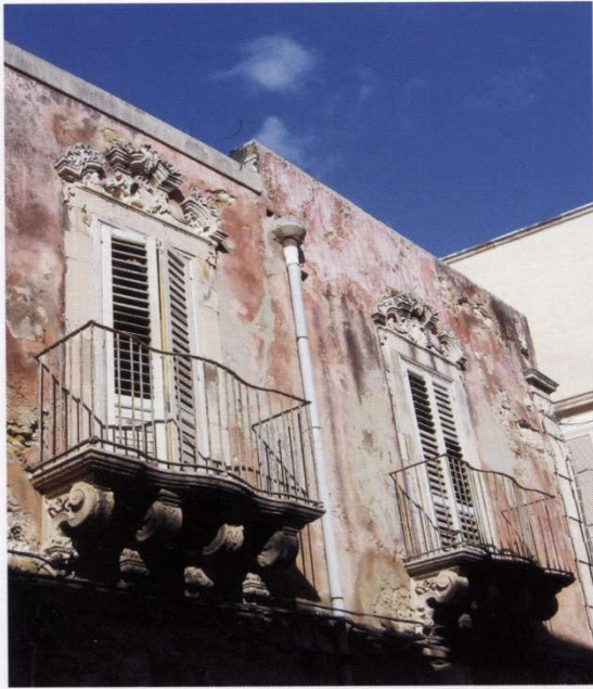
4.13 - La casa dell'arch. Luciano Ali. In stato di abbandono
