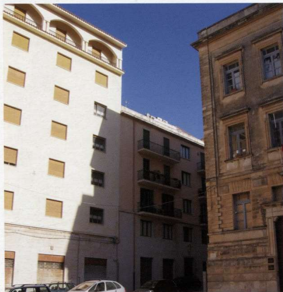
4.1.4.2 - Via Santi Coronati, condominio
