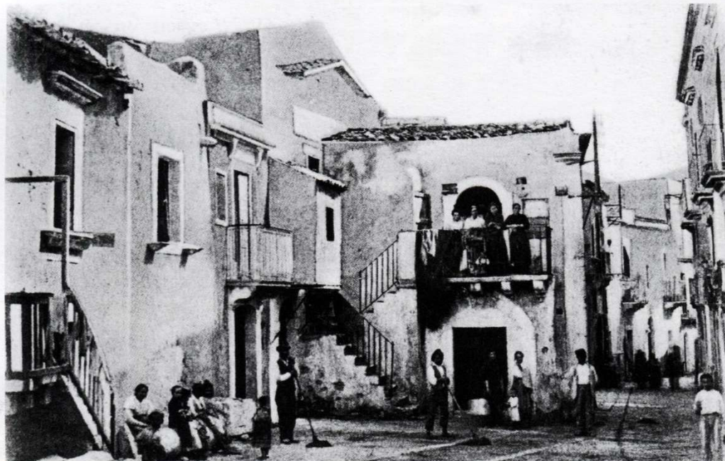
1.10 - Via dei Gracchi, tipico scorcio medievale demolito nei primi anni del '900. A. Magni
