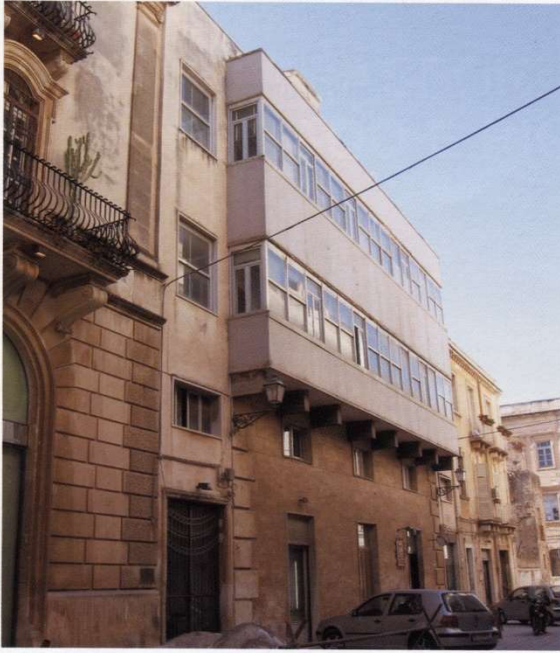
4.3 - Via Santi Coronati, edificio per uffici
