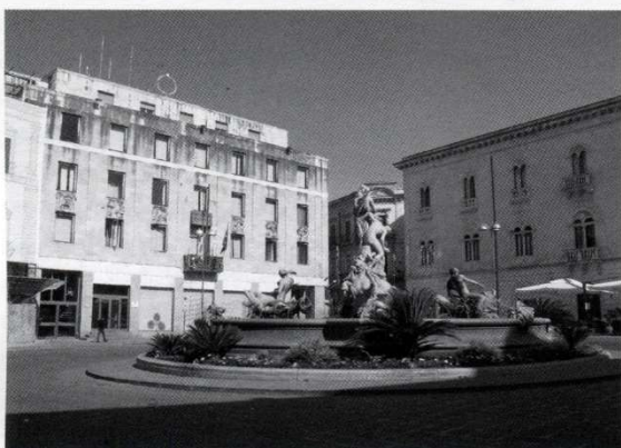
2.30 - Piazza Archimede Oggi. L'edificio dell'ex Cassa di Risparmio ha sostituito l'antico palazzo Zummo. Foto Liistro 2009
