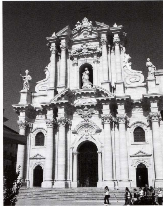
2.20 - La facciata del Duomo dopo il restauro. Foto Liistro 2008
