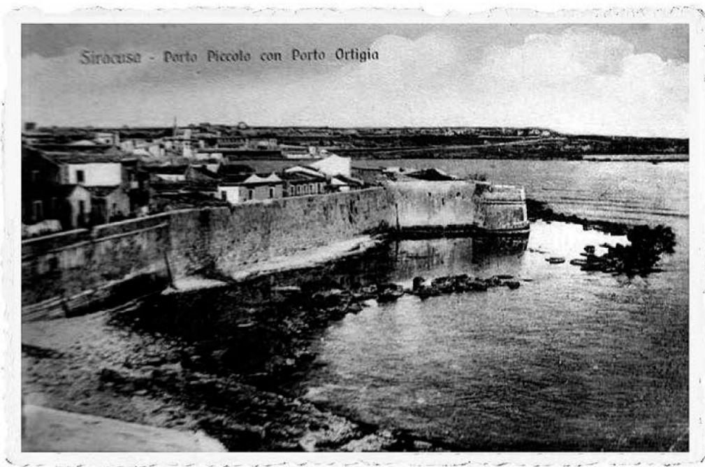
Mastrarua- Santa Croce- forte San Giovanniello deposito spazzatura
