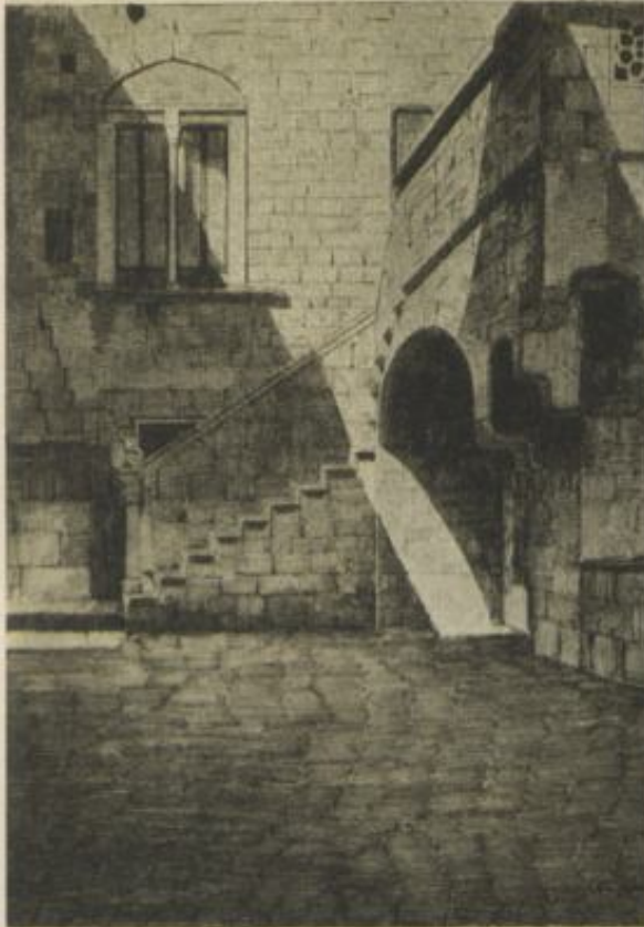
28) - Cortile del palazzo della Banca d'Italia.
