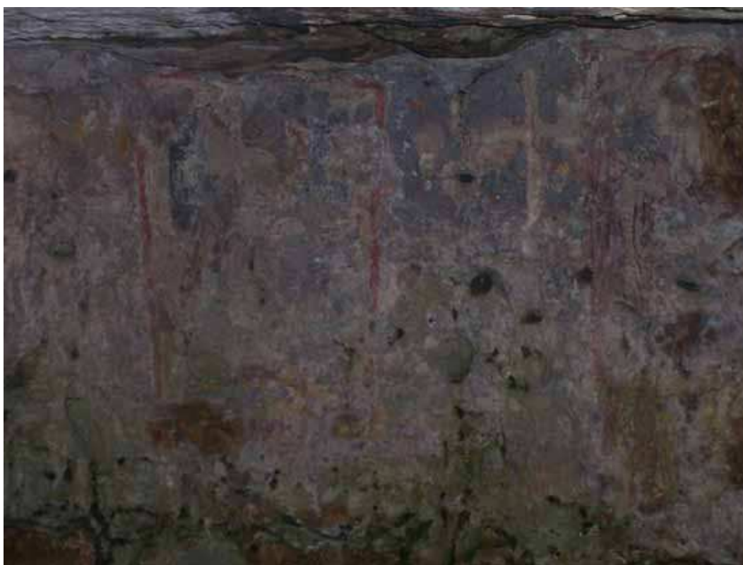
Figura 10 La chiesetta rupestre di S. Nicola, particolare dello stato attuale della decorazione
