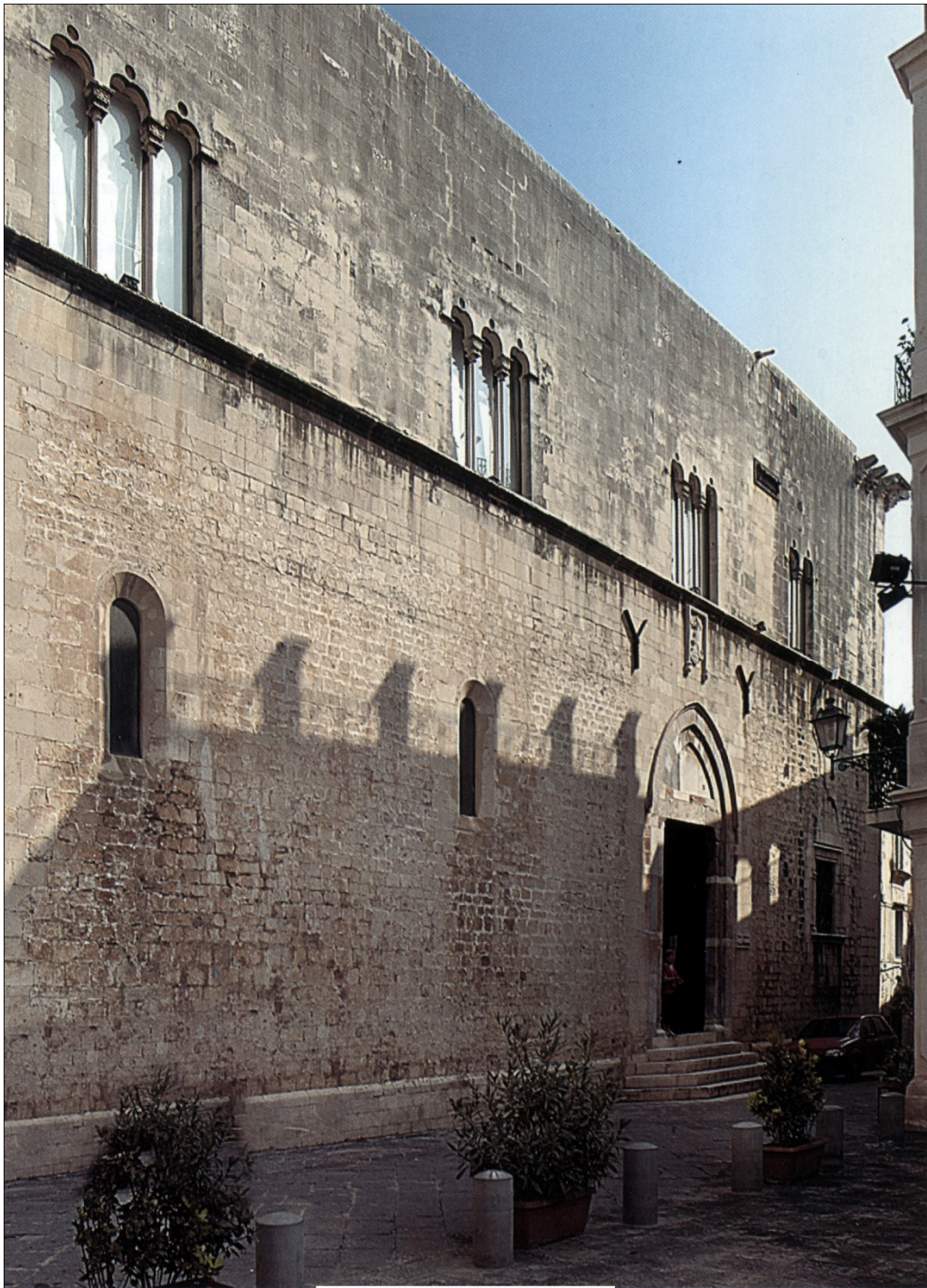
Prospetto, Palazzo Bellomo - Siracusa.
