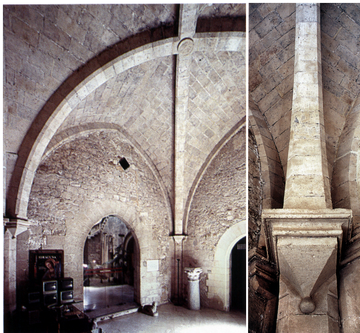
Particolare della volta: costoloni e peduccio a goccia nel vestibolo Palazzo Bellomo.
