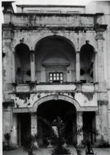
Cortile interno e loggia di Palazzo Bonanno.
