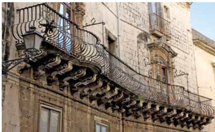
Siracusa. Palazzo Rizza ex Casa Danieli. Particolare del balcone con innesto di elementi decorativi barocchi su muratura del XV secolo.
