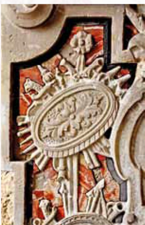
Particolare della cornice dello stemma nella scala
