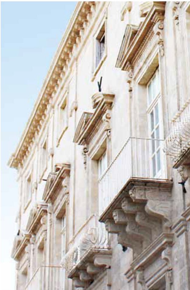
Siracusa. Palazzo Bufardecì. Balconi e particolare delle mensole.
