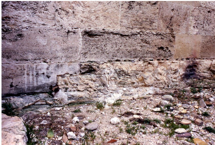
Fig. 03 - Il muro sud-occidentale. Lo spianamento del banco di roccia per la posa dei conci; a destra si vede il curioso metodo di livellamento di precisione ottenuto mediante la rinzepatura effettuata con elementi minuti.
