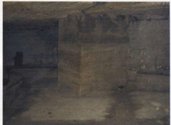
Fig. 3.2. Ipogeo Chiesa di S. Francesco di Paola e Convento dei Minimi in via Logoteta - In primo piano il contrafforte e le sedute utilizzate durante i bombardamenti del 1940-43.
