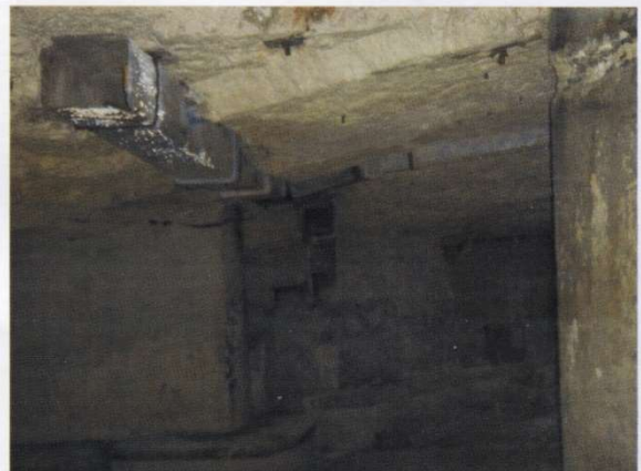
Fig. 3.4. Ipogeo Chiesa di S. Francesco di Paola e Convento dei Minimi in via Logoteta - Particolare della canaletta per l'aria forzata utilizzata durante i bombardamenti del 1940-43.
