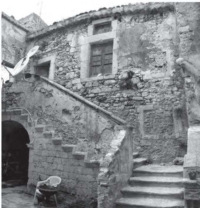
Fig. 3 – La scala catalana all'interno del cortile di pertinenza dell'edificio (foto di F. Fazio).
