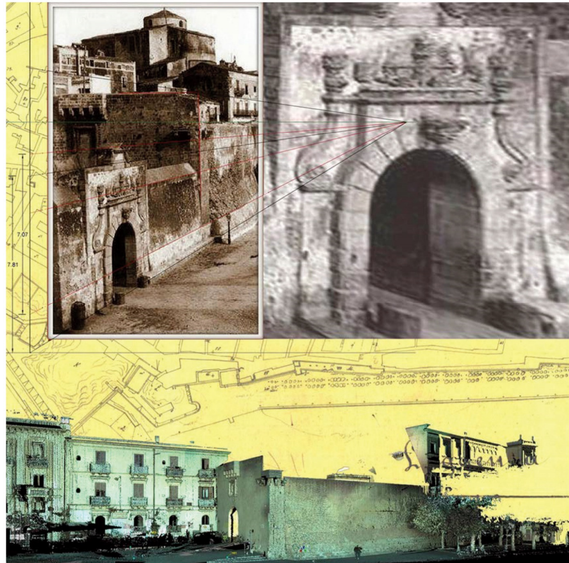
Fig. 11. Terza metodologia: ricostruzione della Porta dell'Aquila. In alto, restituzione prospettica; in basso, rilievo del frammento esistente
