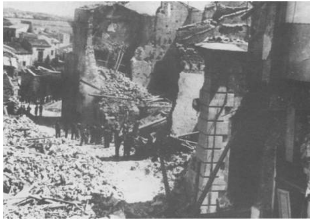
Siracusa - Si lavora per togliere le macerie, in via dei Santi Coronati, dopo un bombardamento (arch. La Rocca)
