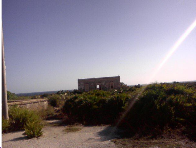
Un edificio abbandonato posto nei pressi del Faro di Capo Murro di Porco.
