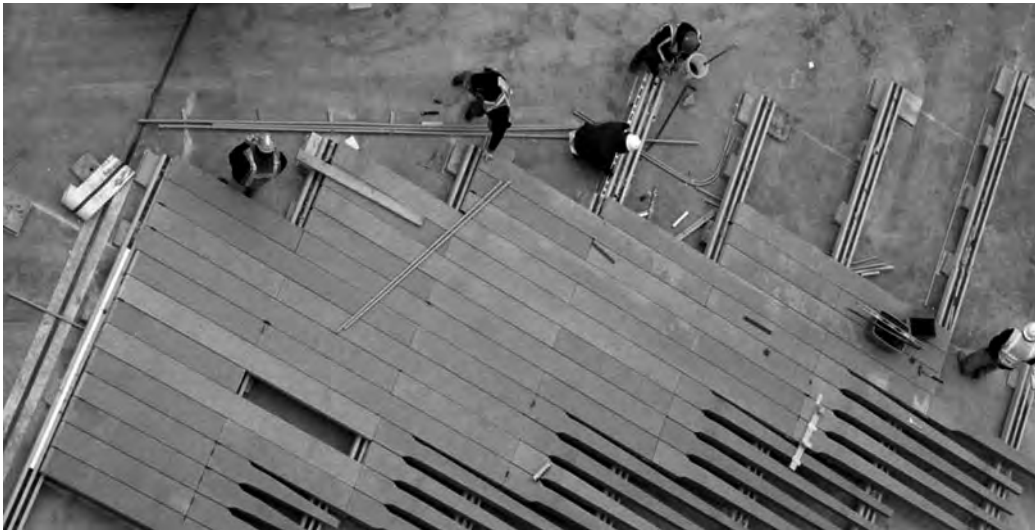
Il montaggio delle traverse in calcestruzzo della pavimentazione, 2009.
