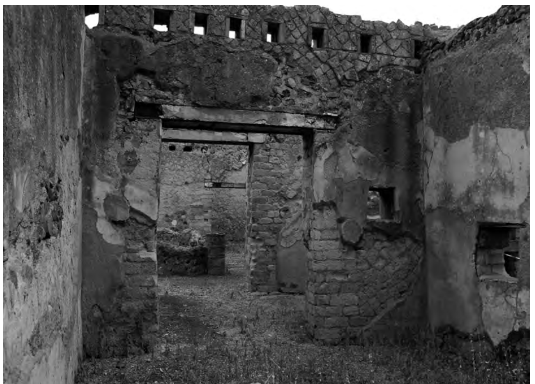
Due scorci di Ercolano, da cui si apprezza la differenza tra le parti coinvolte dagli interventi compiuti nell'ambito dell'Herculaneum Conservation Project e quelle che ancora versano in stato di abbandono (2010).
