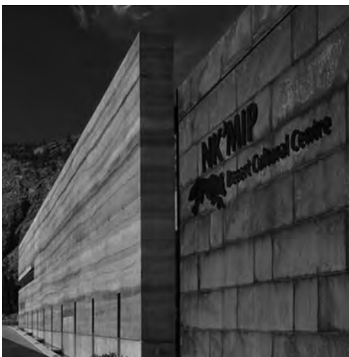
Il muro realizzato in pisé nel Centro Culturale NK'MIP in Canada.
