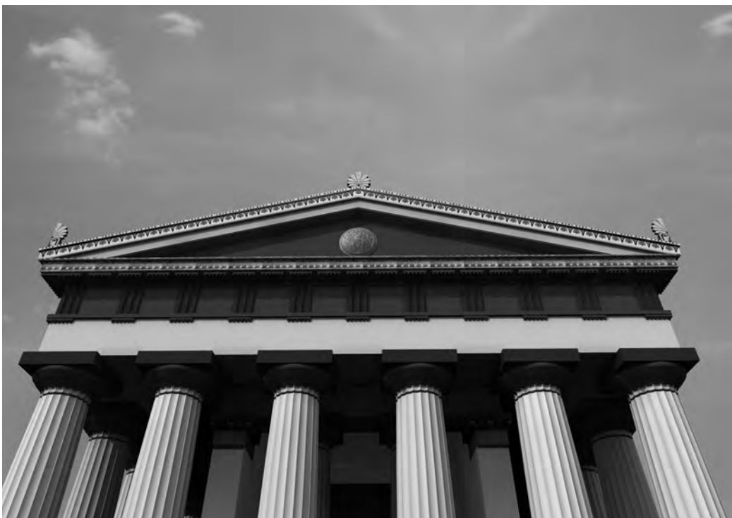
Particolare del frontone Est.
