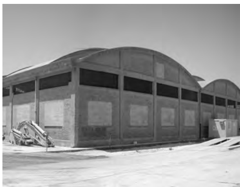
Il fabbricato officina e magazzino scorte.
