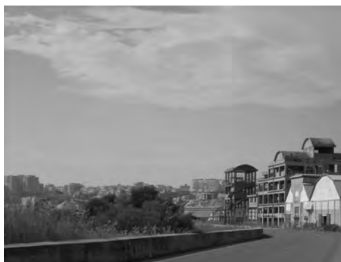
L'impianto nitrato potassico: il magazzino doppio.
