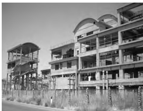
L'impianto a doppio scambio.
