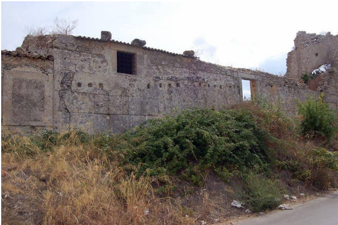
Fig. 61 – San Lorenzo Vecchio (Noto), strutture di edificio templare, presunto tempio di Apollo Lybistinus (?) inglobate in una masseria settecentesca (foto Piazza)
