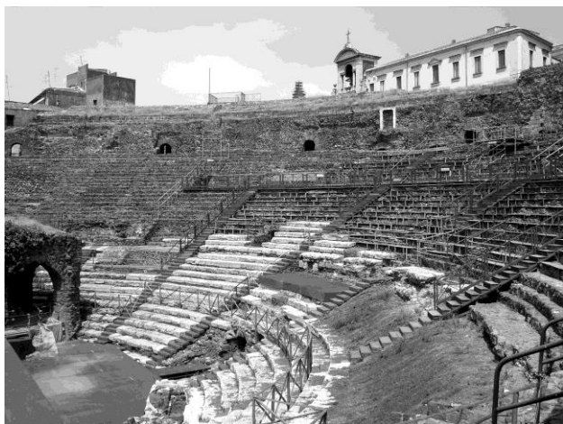
Fig. 17 - Teatro antico di Catania. Sedute in acciaio e legno costruite negli anni '70, oggi rimosse.
