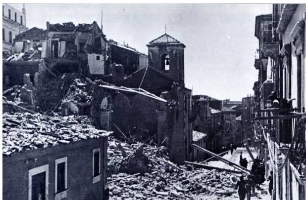
Fig. 1 - Chiesa di Santa Maria della Cava dopo il bombardamento aereo del 16 aprile del 1943 ( Archivio del Parco Archeologico e Paesaggistico di Catania e della Valle dell'Acì, già edito da Lopatriello 2008 ).
