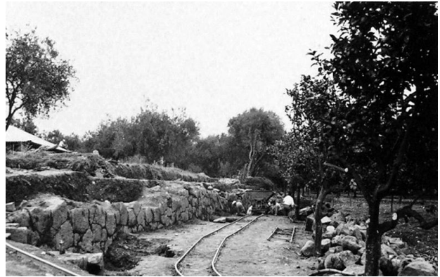
Fig. 5 - Veduta del Muro D in corso di scavo (1955).
