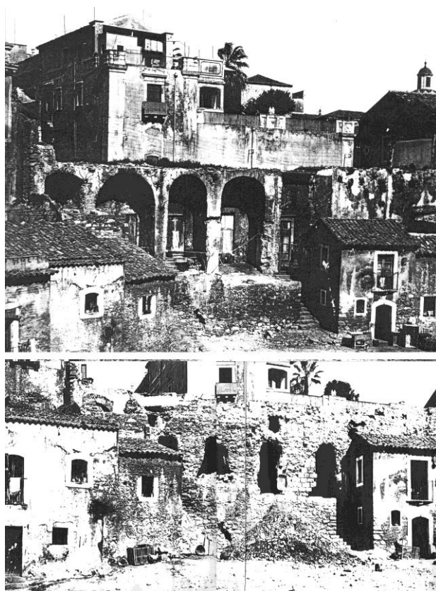
Fig. 8 - Teatro antico di Catania. Liberazione della porzione centrale del terzo ambulacro. In alto prima degli abbattimenti, in basso subito dopo (1948).
