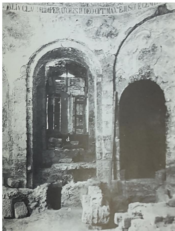
Fig. 6 - Portale occidentale della Rotonda con indicazione (a, b, c, d) dei livelli pavimentali individuati (da Libertini 1953).
