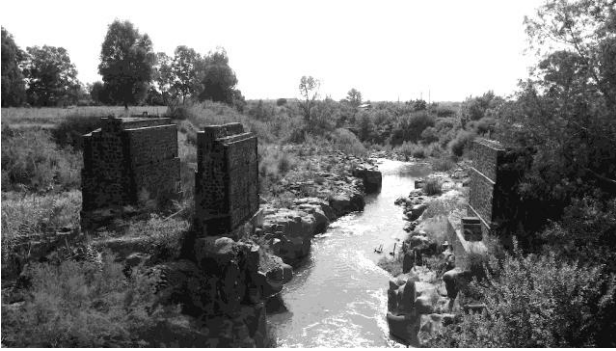
Fig. 7 - Il ponte Al Quantarah sul fiume Alcantara.
