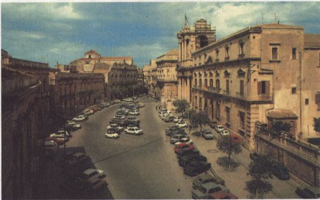
Fig. 12 - Piazza Duomo prima dei lavori di pavimentazione vista da sud.
