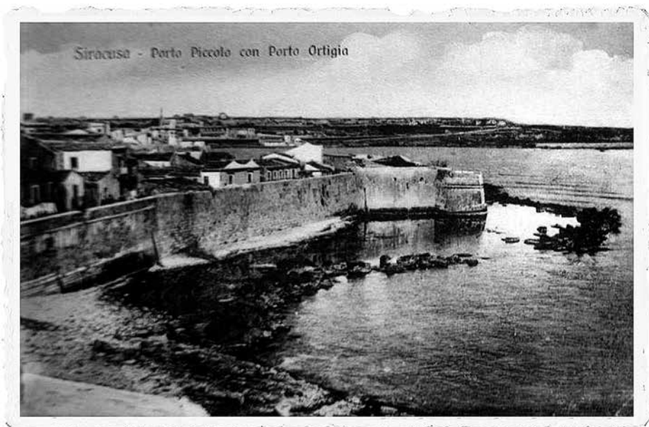
Mastrarua- Santa Croce- forte San Giovannello deposito spazzatura
