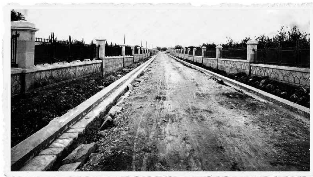
Ingresso monumentale ospedale psichiatrico
