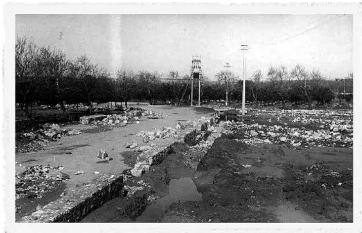
Contrada Pantanelli dopo l'alluvione del 1951
