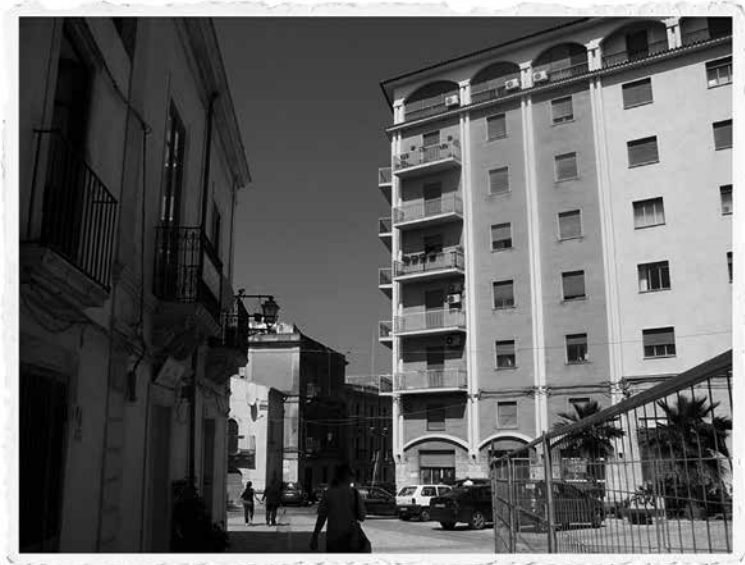
L'edificio costruito tra le via Gargallo e via dei Mergulense
