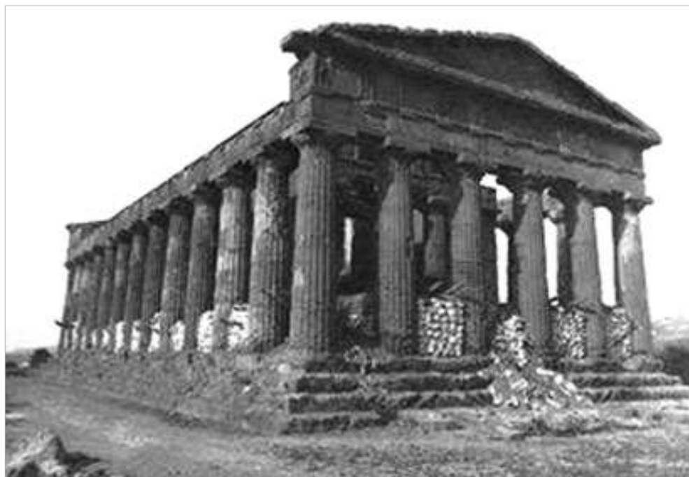
Fig. 2. Smontaggio dei sacchi di sabbia da parte di P. Griffo
